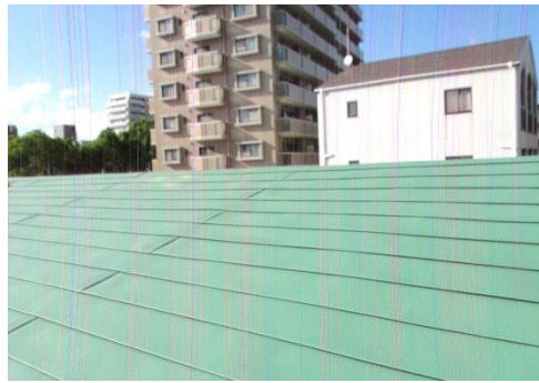
完成した、庫裡屋根ステンレス鋼板 仕上げ工事
