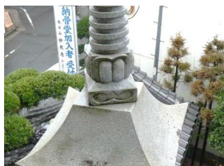
平成17年福岡西方沖地震により塔身よりずれた相輪
