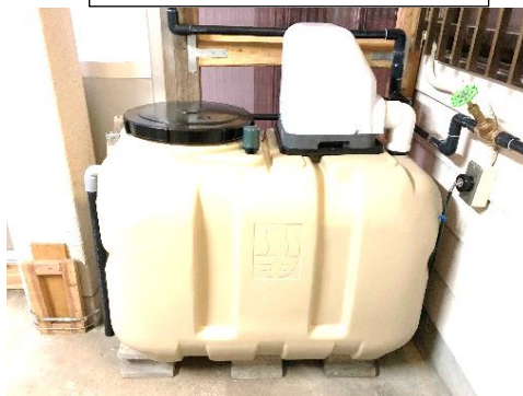
庫裡3階用給水ポンプ設置工事
