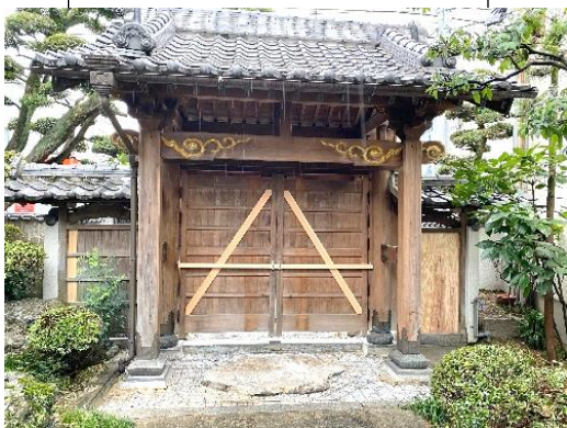
段差工事に併せ扉の補修工事
