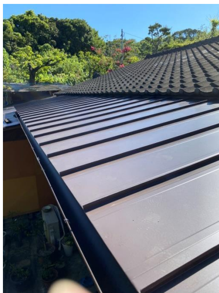
8/1 本堂横廊下屋根 ガリバリウム鋼板へ 葺き替え工事終了
